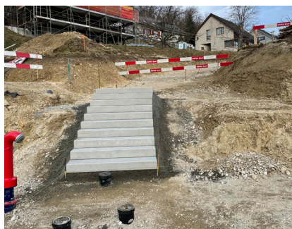
Die Treppe zum Thomas Mosimann Wägli ist bereits fertig. (Foto: Raymond Tanner)
