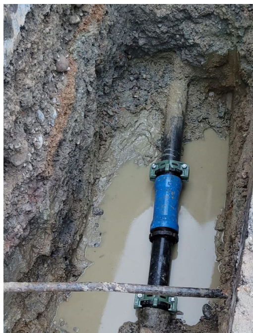
Reparierte Schadstelle mit einer Manschette
