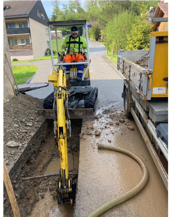
Aufgrabung um eine kleine Querleitung
