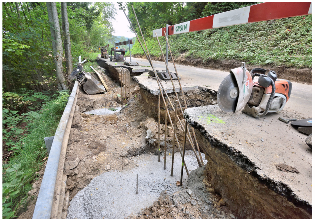
Stützung der Ulmetstrasse beim Stellehübel mit Betonsporen. (Photo: Thomas Mosimann)
