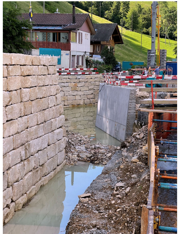
Neue Stützmauern bei der Abzweigung nach Seewen.
