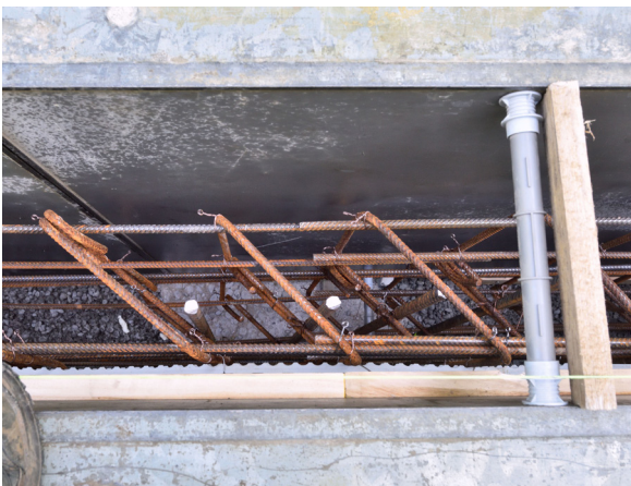
Die Eisenstangen der Betonsporen ragen in die Armierung der Stützmauer hinein.
