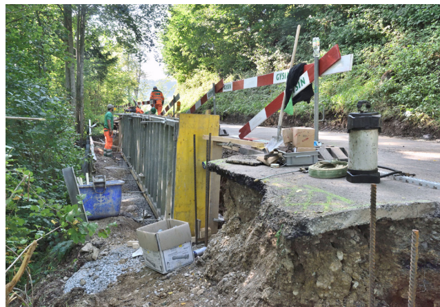
Schalen der Stützmauer in drei Abschnitten.
