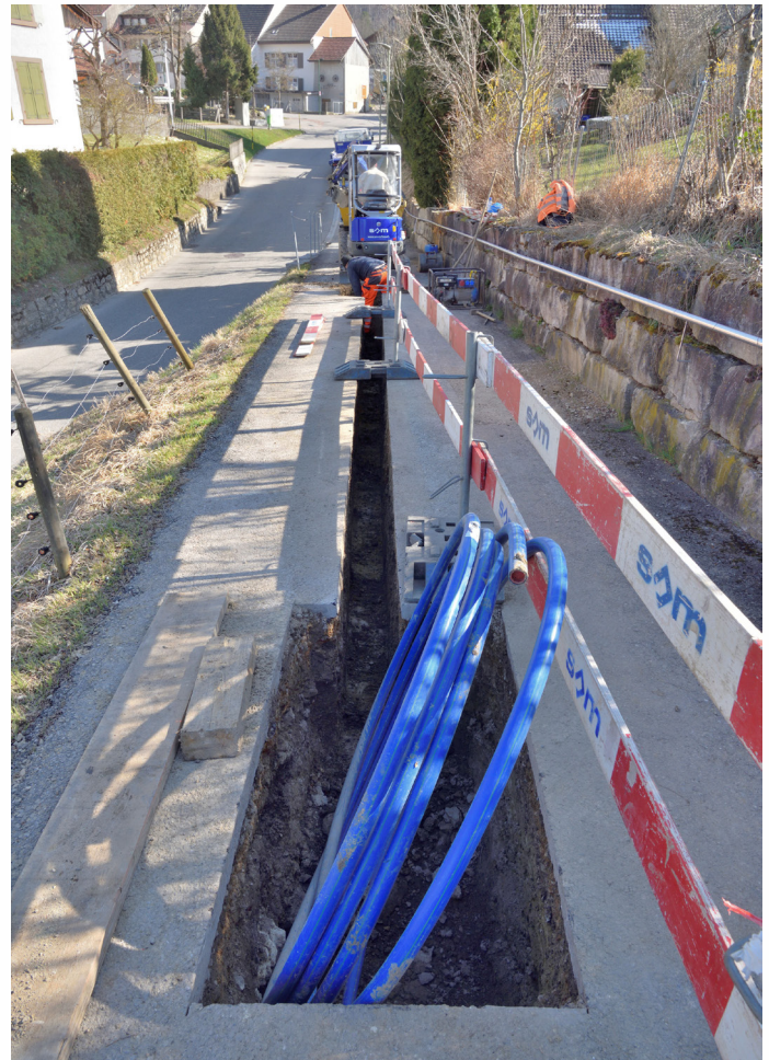
Neue Wasserleitung zum Friedhof. (Photo: Thomas Mosimann)
