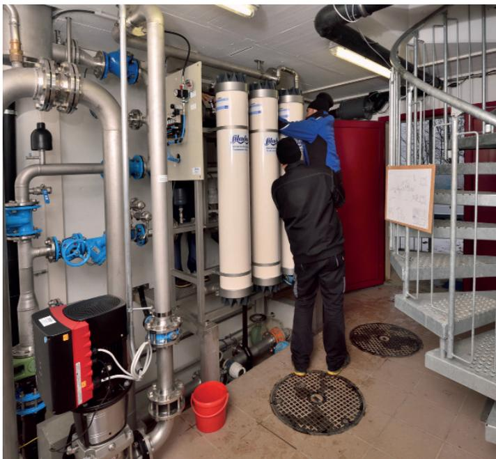
Ultrafilteranlage mit drei Membranmodulen
