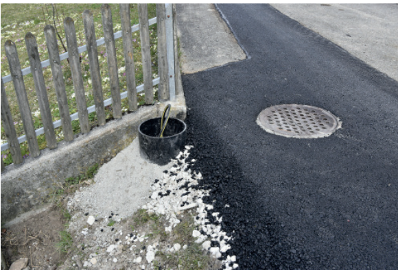
Neue unterirdische Stromleitung am Hörnliweg. Unten Fundament für den neuen Kandelaber.
