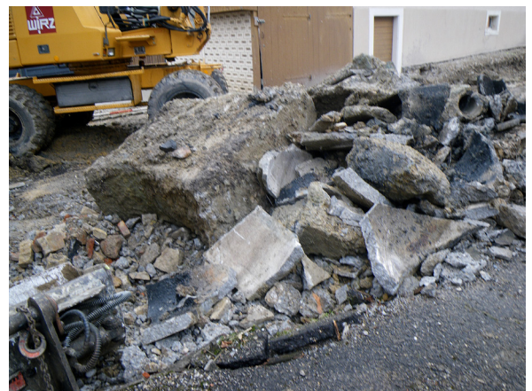
Auskoffierung des Stolten-/Mattenwegs. Der grösste Teil des Materials bestand aus Bauschutt, welcher zur Füllung der alten Strasse benutzt wurde.
