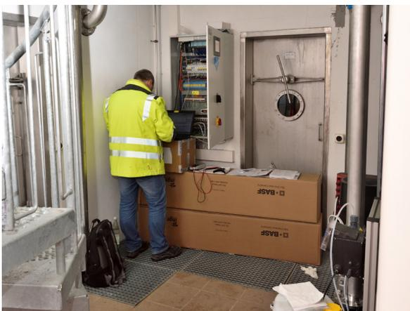
Programmierung der Steuerung der Ultrafilteranlage am neuen Schaltkasten.
