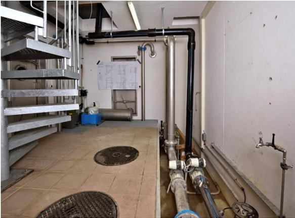
Provisorische Zuleitung des Rohwassers mit schwarzen Kunststoffrohren in die Reservoirkammern.
