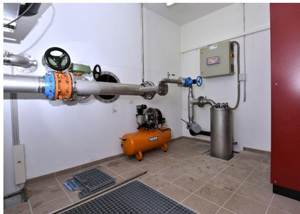
Die Ultraviolett-Bestrahlungsanlage (der senkrecht durch den Boden ragende Metallzylinder) ist in der ersten Etage neu montiert und wieder an den Rohwassereinfluss angeschlossen.
