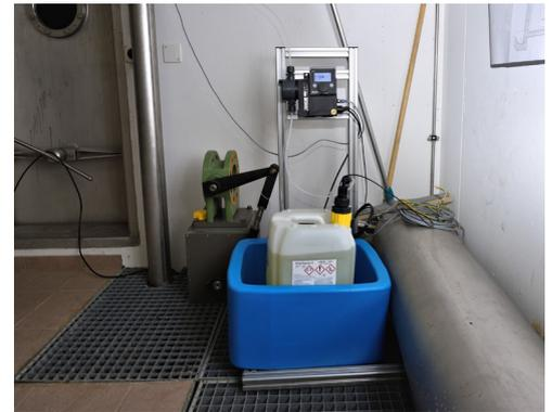
Die Chlorierungsanlage mit der schwarzen Dosiereinheit am Gestell.
