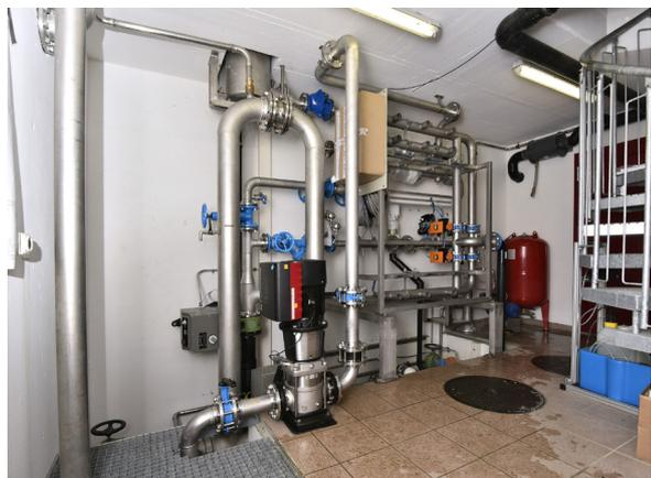
Die Ultrafiltereinheit ist bereits weitgehend ans Rohrsystem angeschlossen und mit der am Boden montierten Rückspülpumpe verbunden.
