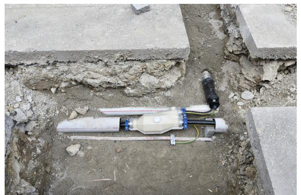
Hauseschluss zum alten Spritzenhaus. Der Anschluss am Hauptkabel ist mit Giessharz fixiert.
