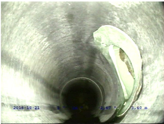
Kanalisation Schulweg 2016: Situation linkes Bild nach der Sanierung.
