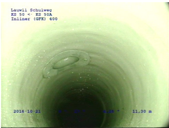
Kanalisation Schulweg: Nach der Sanierung mit Inliner.
