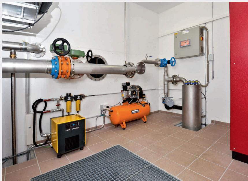
Fig. 11 Kompressor und Kältetrockner der Steuerluftversorgung für die Steuer- und Absperrklappen der Ultrafilteranlage. Rechts die in die erste Etage versetzte bisherige UV-Anlage mit Steuerschrank.
