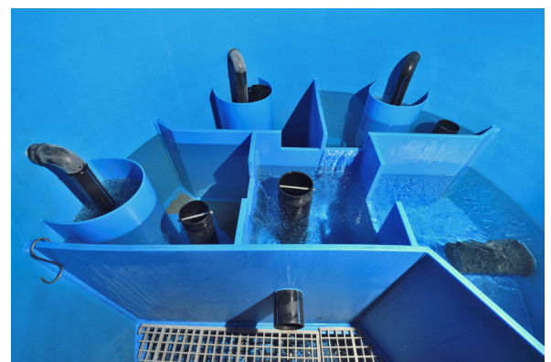
Blick auf die verschiedenen Becken der Brunnenstube. Links und oben die Einläufe der drei Bürtengrabenquellen. (Photo: Thomas Mosimann)
